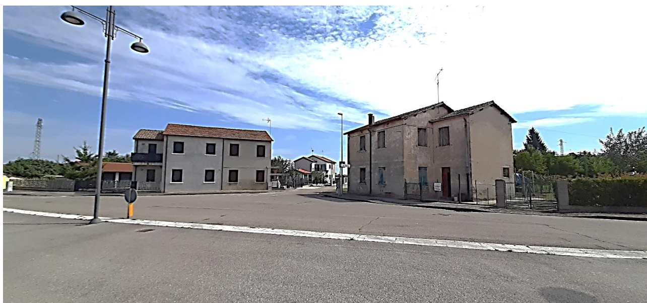
FOTO 3 – PROSPETTO SUD DA VIA VII STRADA
