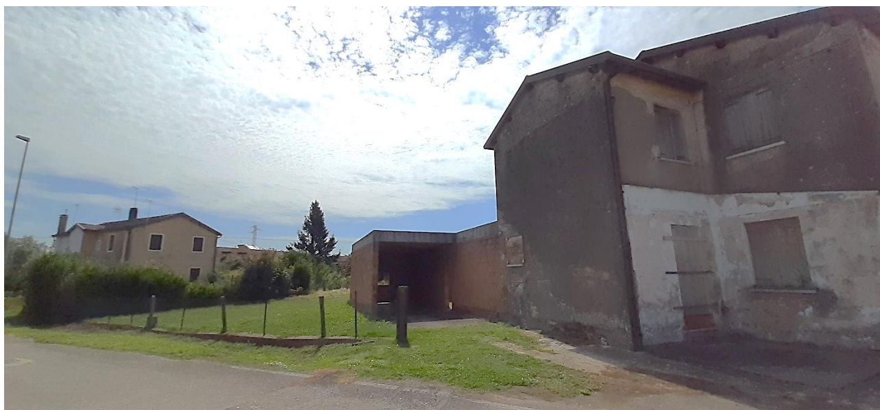
FOTO 2 – PROSPETTO NORD-OVEST DA VIA III STRADA
