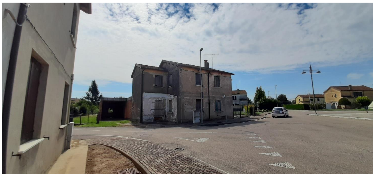
FOTO 6 – PROSPETTO OVEST DA VIA IIV STRADA
