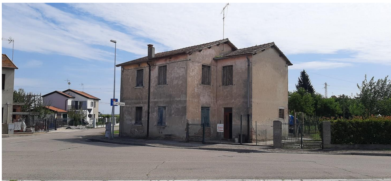
FOTO 4 – PROSPETTO SUD DA VIA VII STRADA
